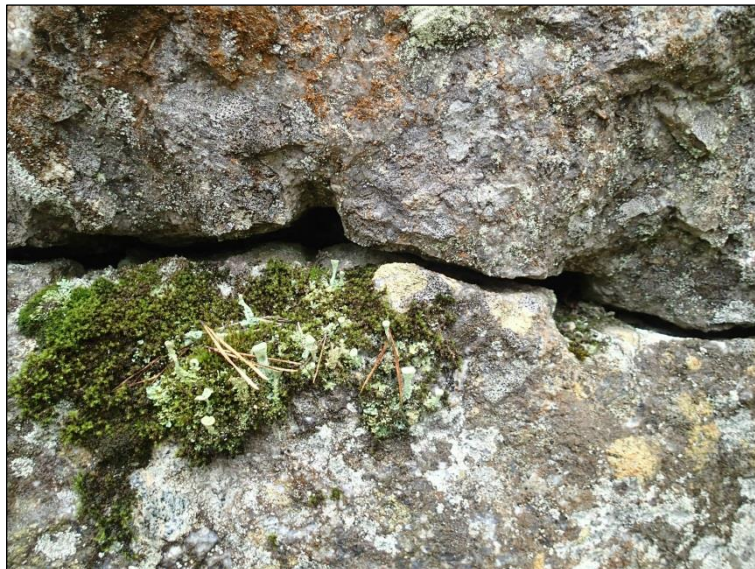
Kallioulouhos. Kiviporan jälkiä kallioraossa.
